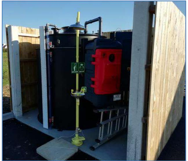
Cuve de chlorure ferrique (traitement du phosphore)
