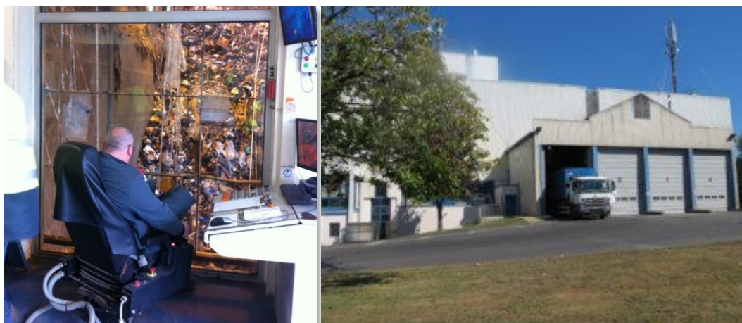
Poste de pilotage du chargement des fours à l'U.V.E de Concarneau et vue extérieure de l'U.V.E.
