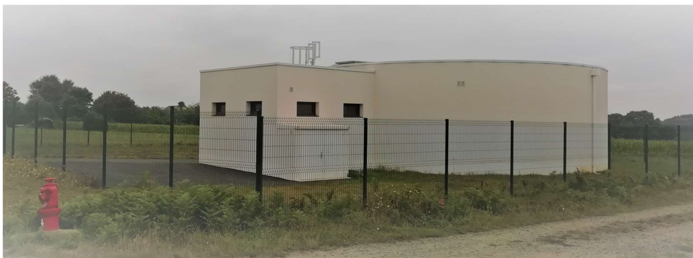
Réservoir de Kerguivien
