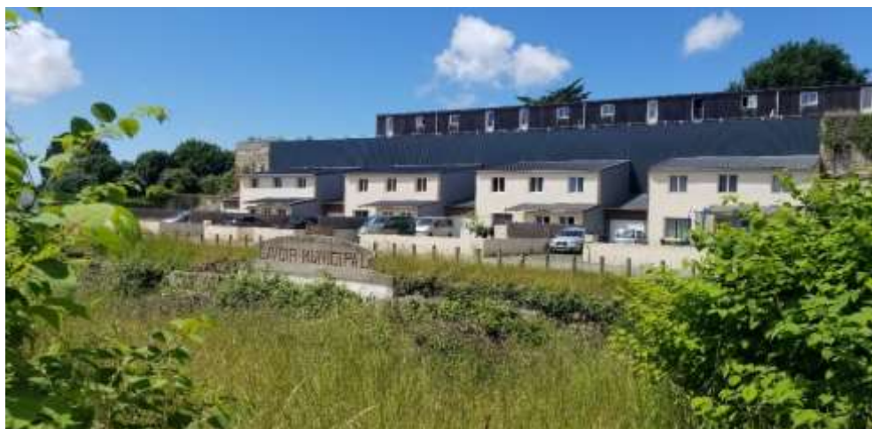
Photo 1 : Ensemble de maisons mitoyennes, rue du moulin d'Hascoët, à Plonéour-Lanvern. (Source : auteur, 2022)
