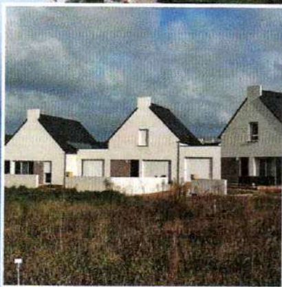
Travaux : La Résidence du Vieux Puits
