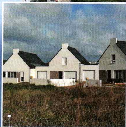
Travaux : La Résidence du Vieux Puits
