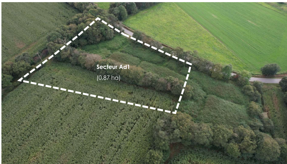
Vue de la zone Ad1 depuis le Nord-Est
