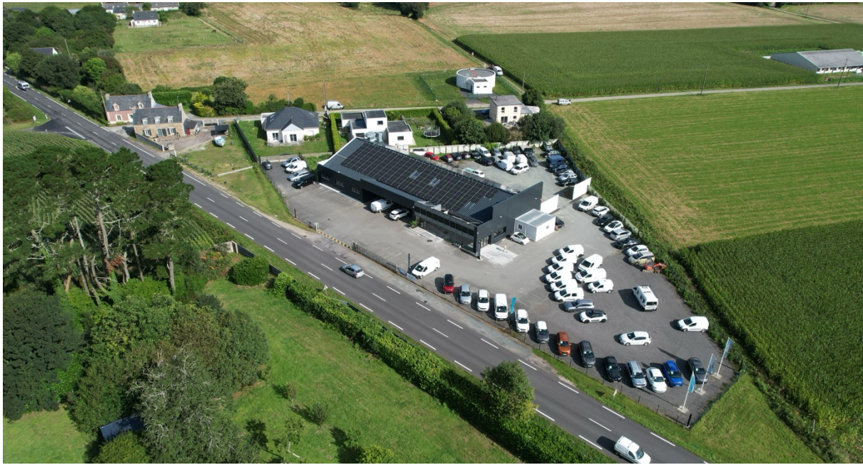
Vue aérienne du garage depuis le Sud
