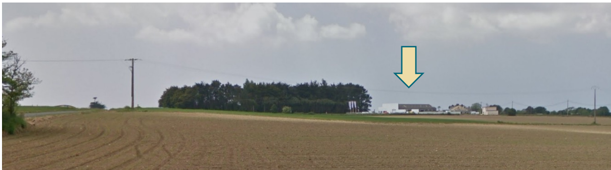
Perception lointaine du garage depuis la rue de Kergonda à l'Est
