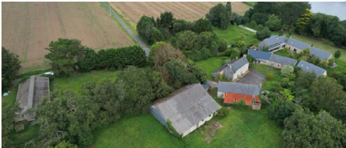
Vue du hameau depuis le Sud-Ouest
